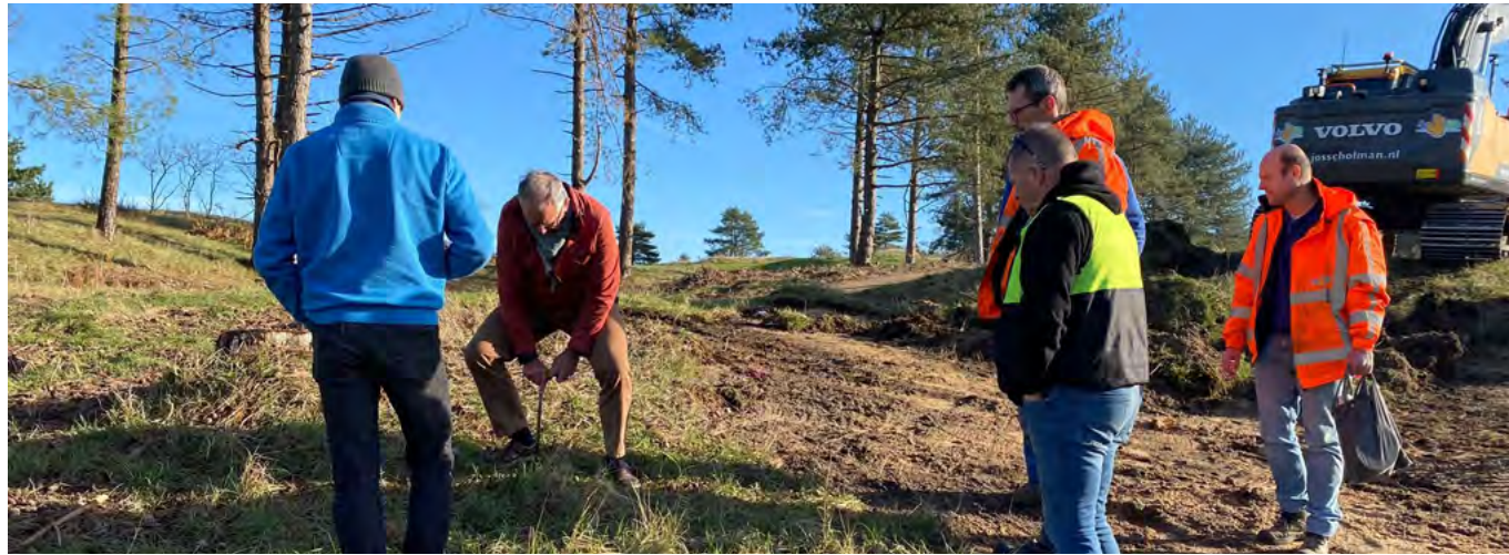
Huiscoloog Harrie van der Hagen laat zien tot waar de toplaag moet worden afgegraven
