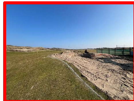
Bunkers in aanleg incl. graszoden (alles binnen witte lijn)
